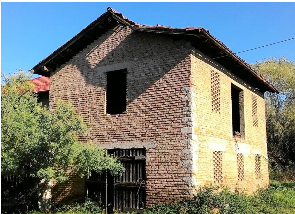
Fig. 2 – Porzione Edificio A2 da demolire e ricostruire
