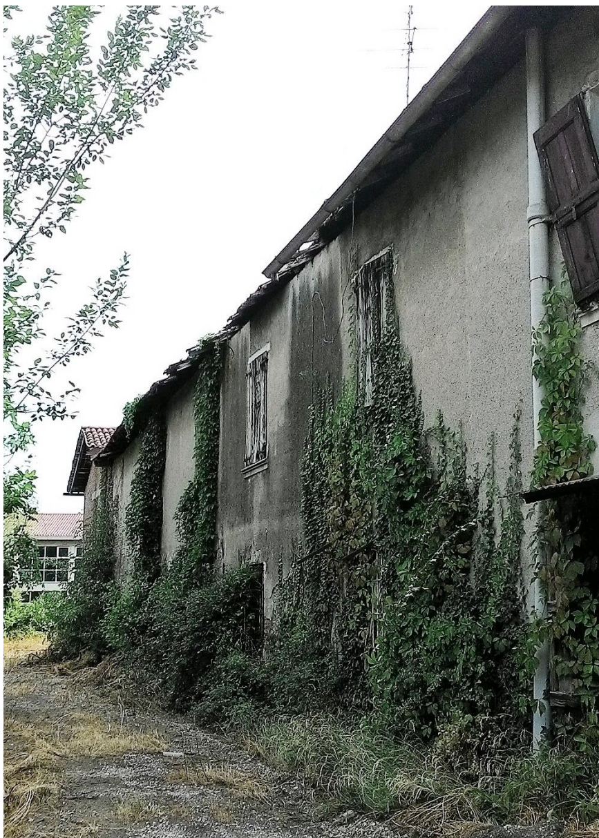
Fig. 5 – Porzione Edificio A2 da demolire e ricostruire
