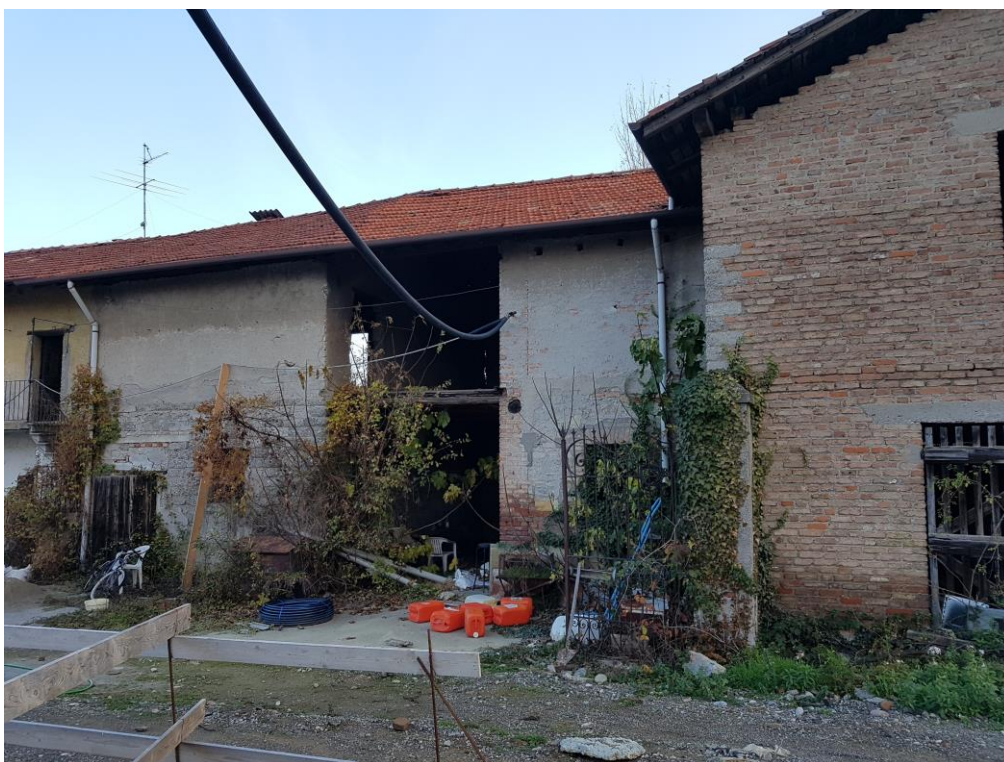
Fig. 3 – Porzione Edificio A2 da demolire e ricostruire
