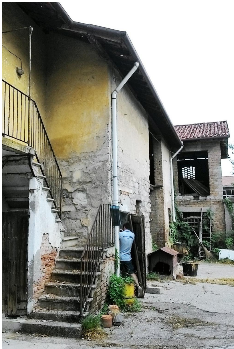
Fig. 4 – Porzione Edificio A2 da demolire e ricostruire
