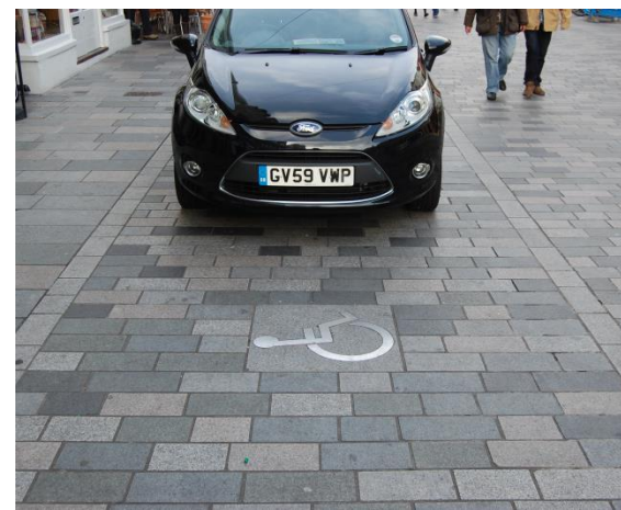
Aree funzionali (es. aree di sosta) realizzate con pavimentazioni differenti
