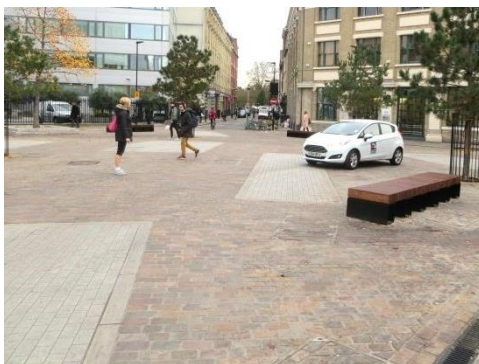
Pavimentazioni usate per unificare visivamente gli spazi, differenziarli dalle strade tipiche così da rallentare il traffico e dare priorità ai pedoni
