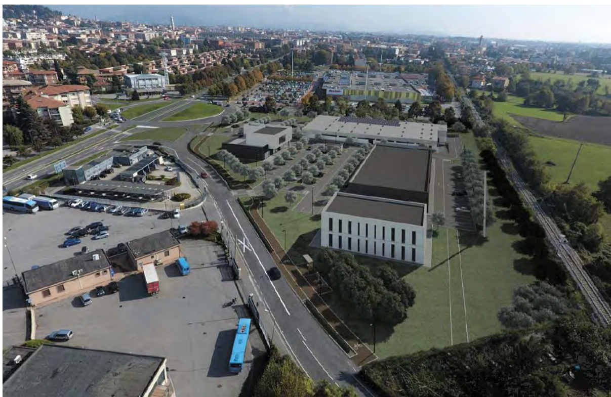
La definizione del nuovo fronte urbano lungo via M.L. King.
