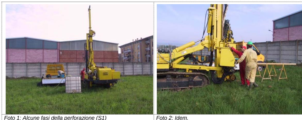
Foto 1: Alcune fasi della perforazione (S1)
