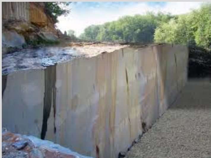
Blocchi in lavorazione
