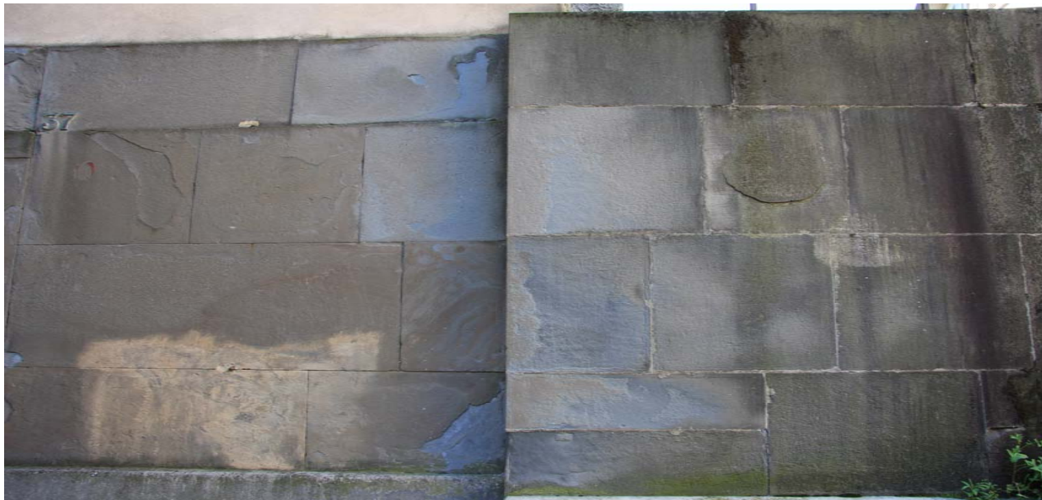
Muratura a conci regolari con accostamento cromatico “turchina” con alterazioni ossidi di Fe Via Porta Dipinta (PD_47 b)
