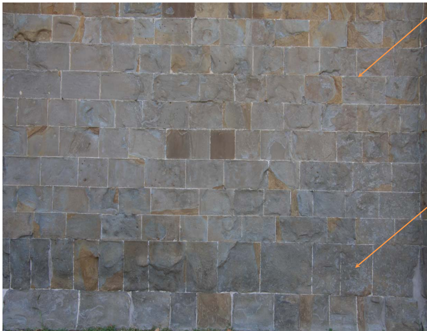
Muratura a conci regolari con accostamento cromatico "turchina" con alterazioni ossidi di Fe Via Porta Dipinta (PD_47 b)
