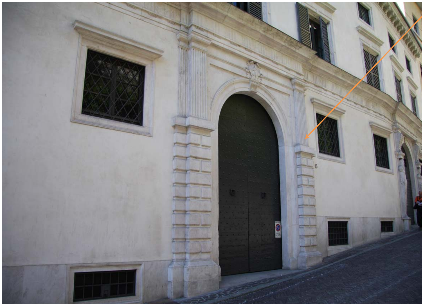
Facciata esterna in Via Porta Dipinta (PD_58-59): utilizzo esclusivo del calcare bianco di Zandobbio
