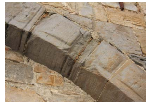
Archi e murature portanti in pietra Arenaria
