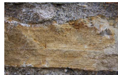
Tamponamenti murari con litologie flischyoidi prevalenti
