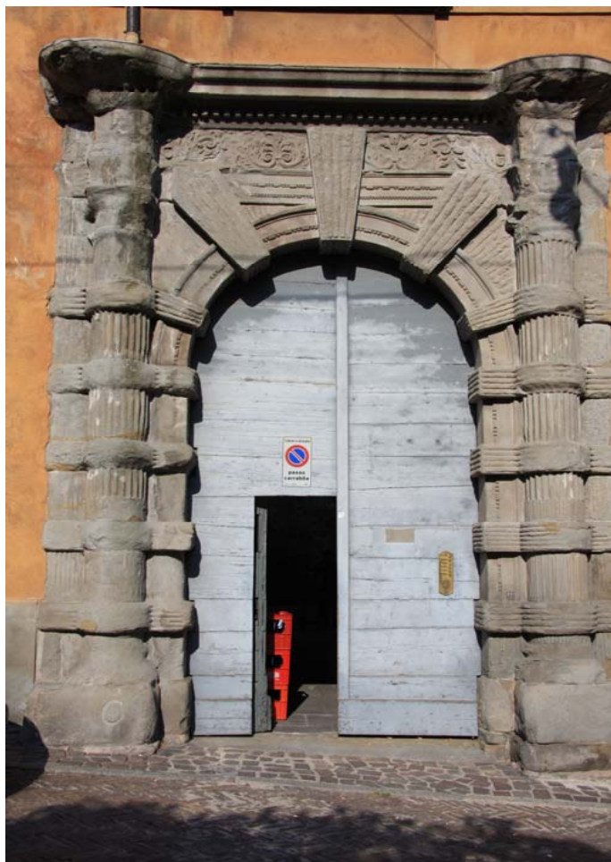
Portale in Pietra Arenaria (Sarnico) lavorato a bugnato di sabbia e punta (PD_15)
