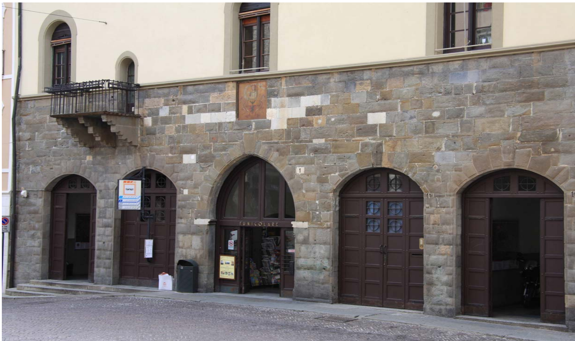
Facciata esterna in Piazza Mercato delle Scarpe (MS_01): accostamento in muratura a vista tra arenaria ed inserti di Calcare di Zandobbio
