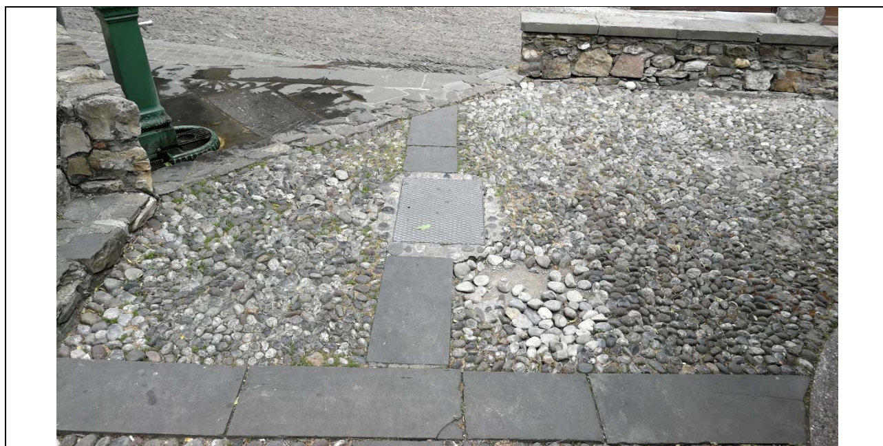
Zona dissestata della pavimentazione in acciottolato della piazzetta
