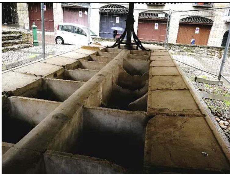
Lastre di separazione e costolature sui piani di lavaggio rotte da vandali
