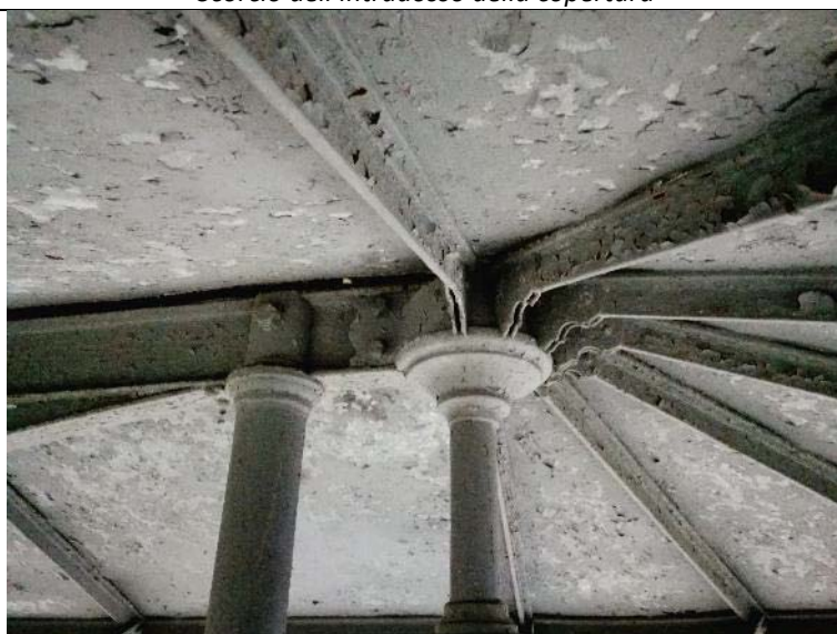
Dettaglio dei supporti montanti di estremità della copertura
