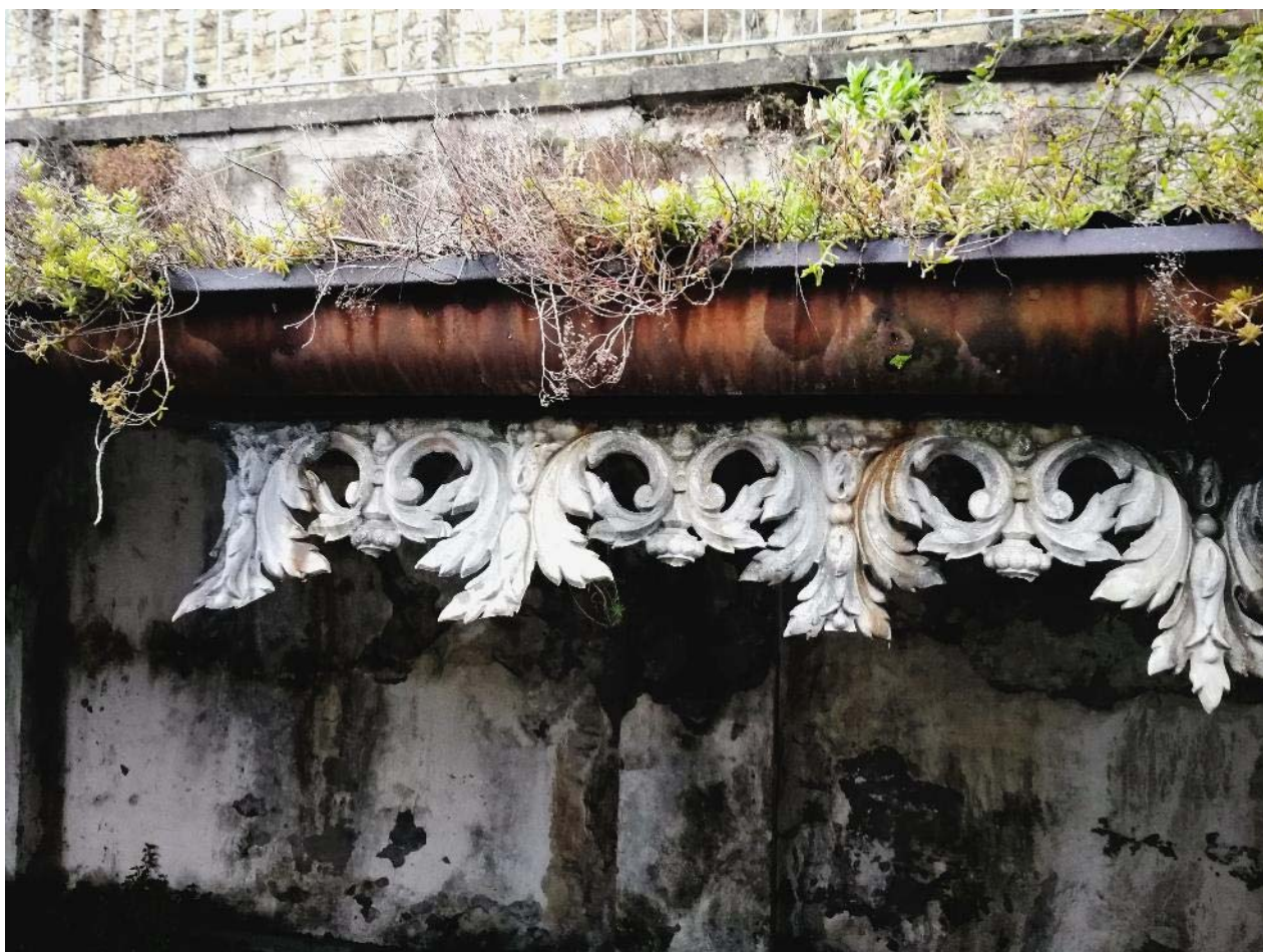
Particolari della copertura: il sottogronda con la lavorazione a fogliame sopra, e le mensole lavorate a volute e travetti in profilati di ferro sotto.
