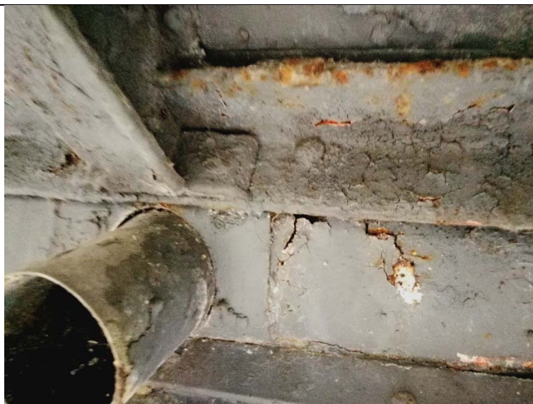
Dettaglio dell'innesto del canale di scarico nella gronda
