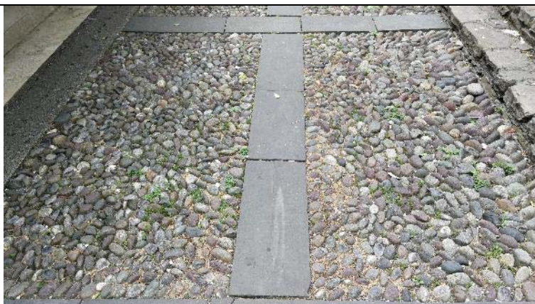
Dettaglio della pavimentazione in acciotolato e fasce di arenaria
