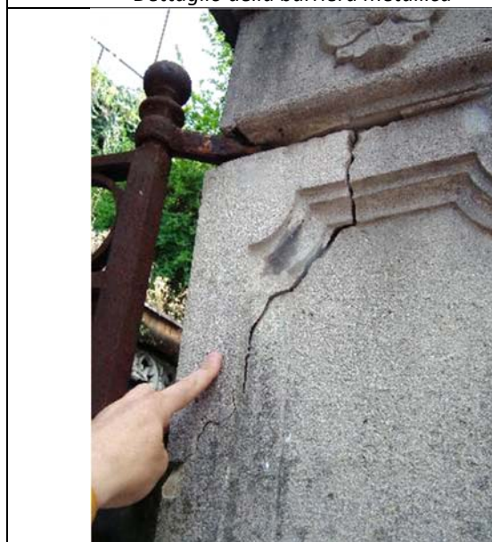
Rottura della colonna
