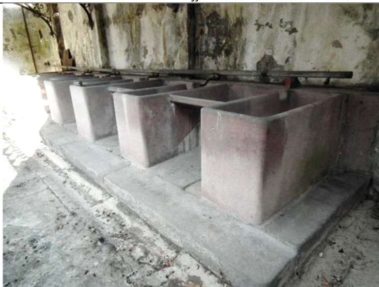
Basamento rialzato in blocchi di arenaria con canale di scarico esterno
