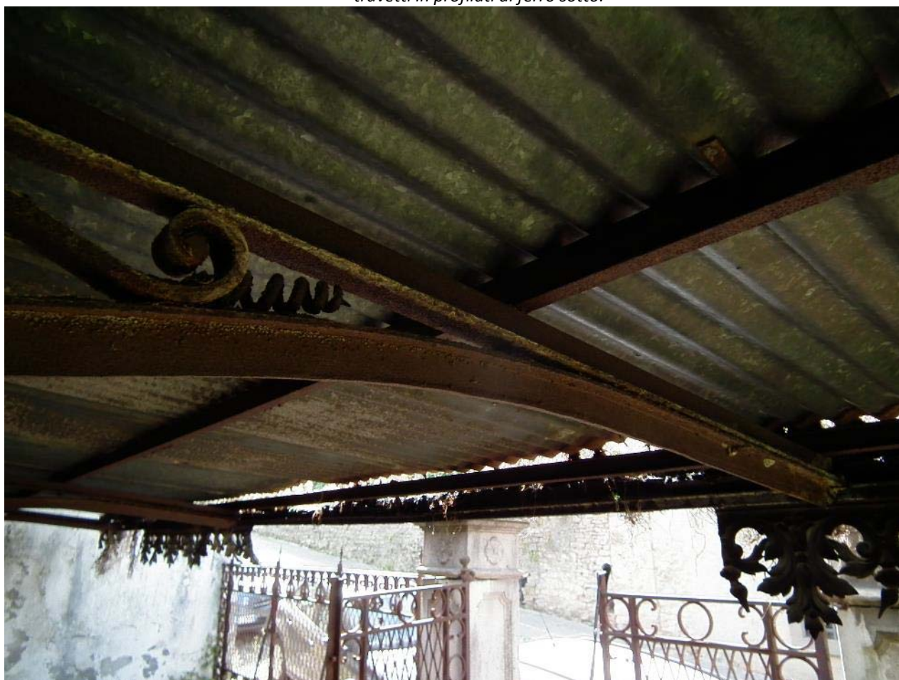
Particolari della copertura: il sottogronda con la lavorazione a fogliame sopra, e le mensole lavorate a volute e travetti in profilati di ferro sotto.
