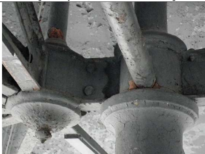
Dettaglio del capitello inferiore della colonna Ovest e del montante adiacente di supporto della parte circolare della copertura
