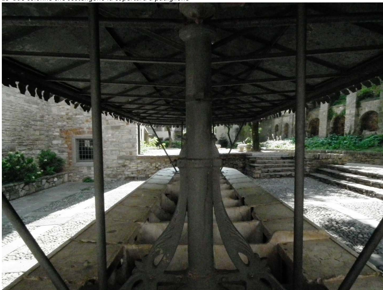
Le due colonne che sostengono la copertura a padiglione
