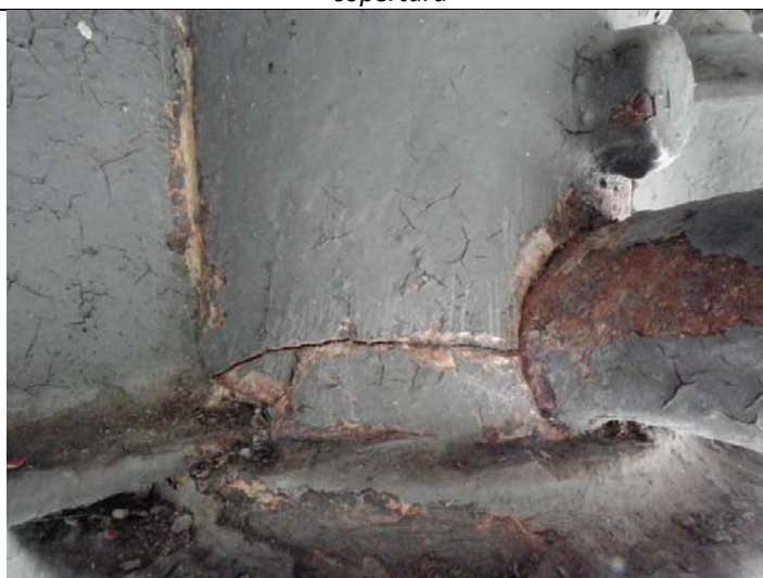
Dettaglio della fessura sul capitello della colonna
