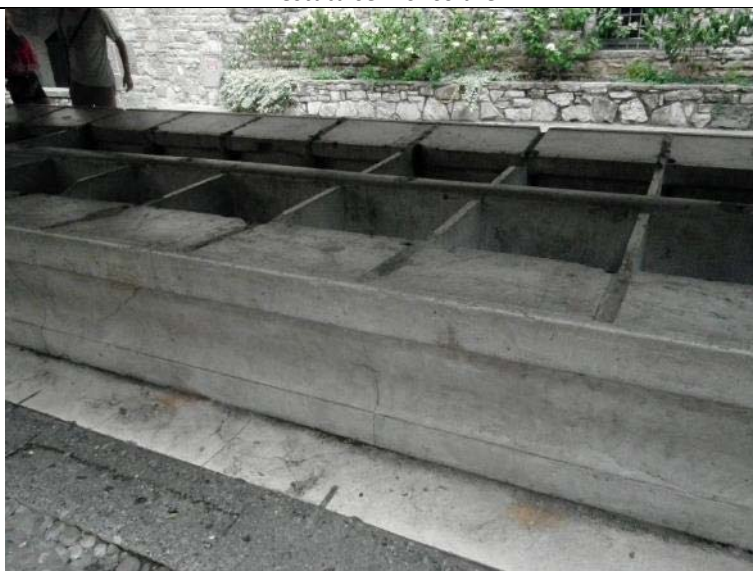
Parte centrale del lavatoio con le vasche affiancate separate da setti di pietra
