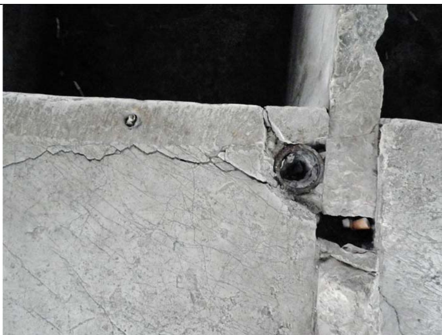
Dettaglio di una delle vasche oggetto di intervento in corrispondenza del setto in pietra di separazione e del tubo metallico di sfioro
