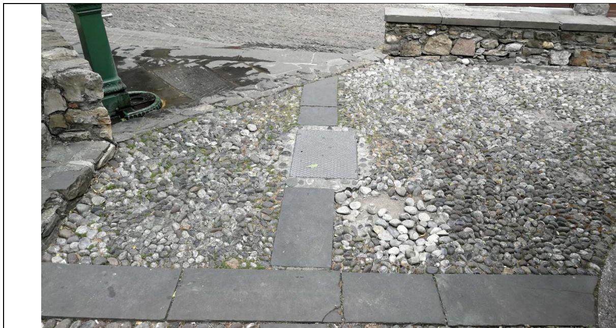
Zona dissestata della pavimentazione in acciottolato della piazzetta
