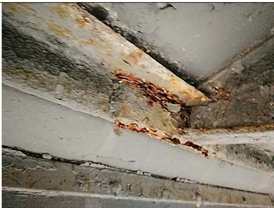
Dettaglio di una zona particolarmente degradata di collegamento sotto falda degli elementi portanti
