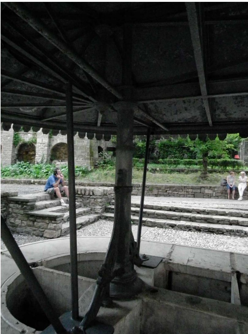
La copertura a padiglione, sorretta da due colonne con travature a capriata, realizzata in ghisa e lamiera
