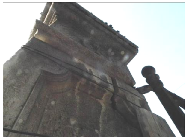
Dettaglio colonna di ingresso fratturata
