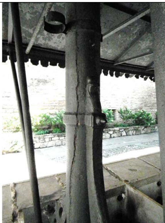
Dettaglio della fessura verticale sulla colonne di ghisa
