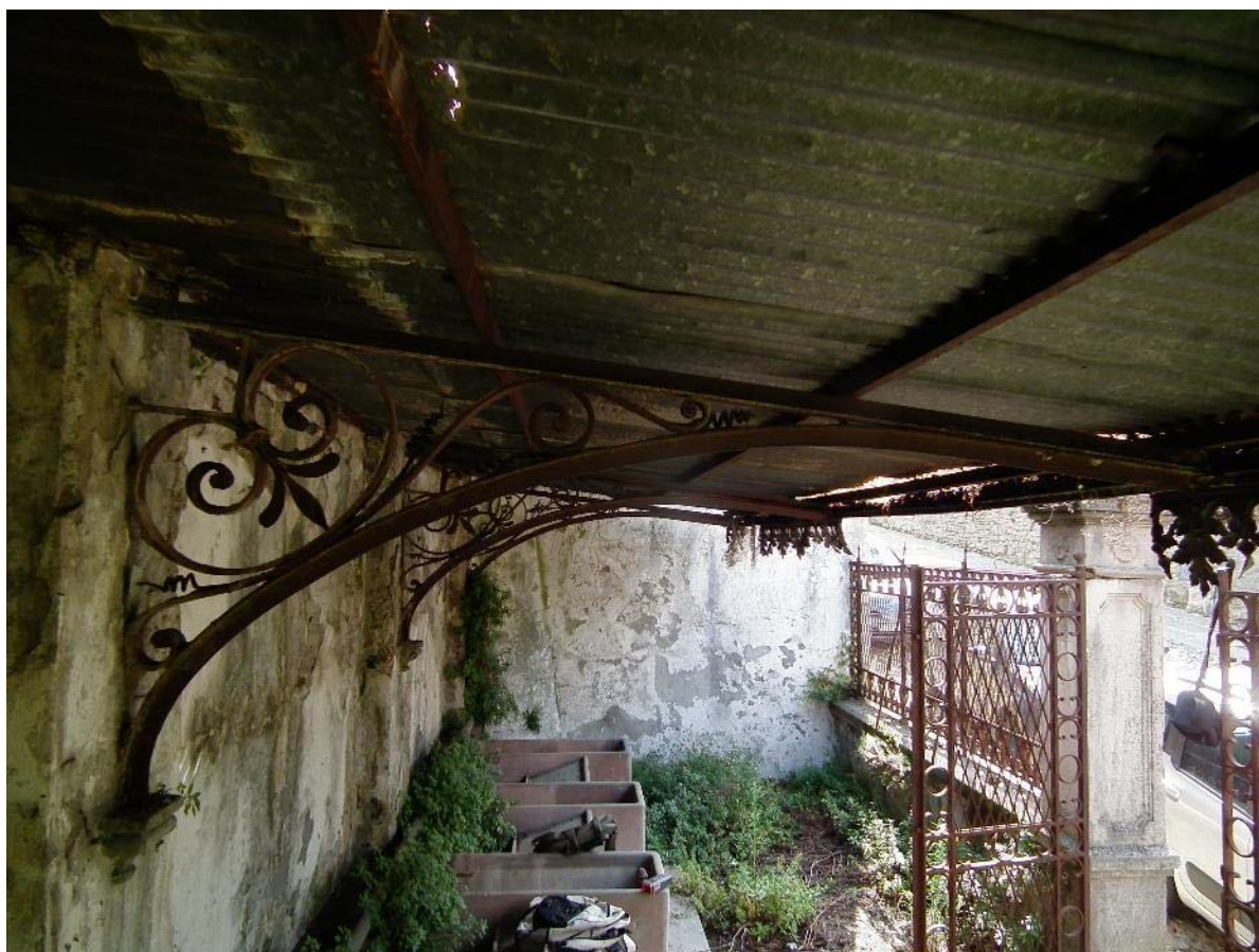
Particolari delle mensole di copertura
