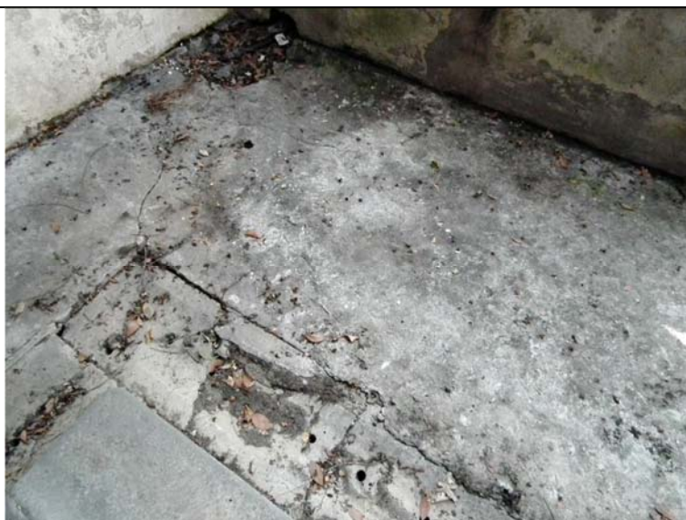
Dettaglio del battuto di cemento e delle lastre forate di chiusura del canale di gronda esterno
