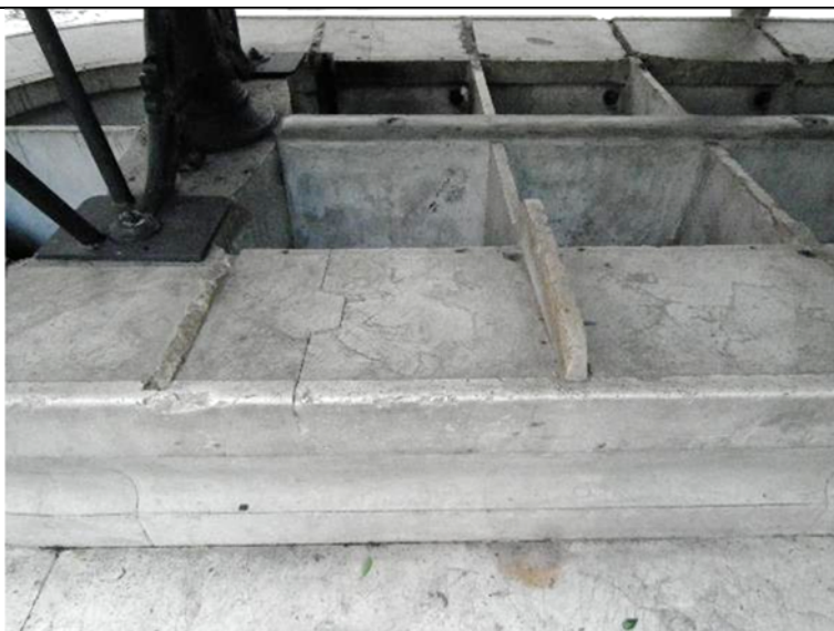
Costolatura di separazione dei piani di lavaggio integra (dx) e danneggiata (sx)
