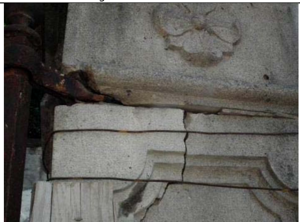
Dettaglio frattura colonna sx e scalzamento del capitello
