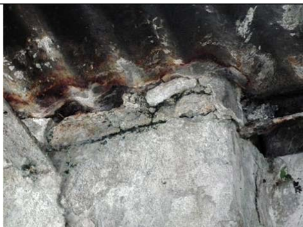
Dettaglio della zona di appoggio del manto sulla mensola
