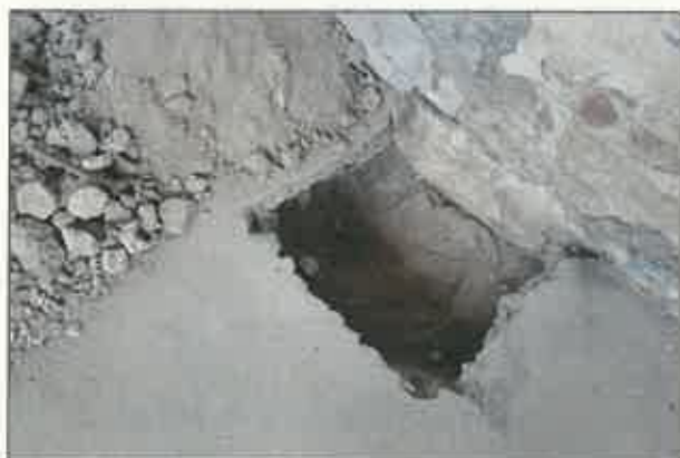
foto 28 – particolare di un'ispezione e materiale di riempimento dei rinfianchi della volta
