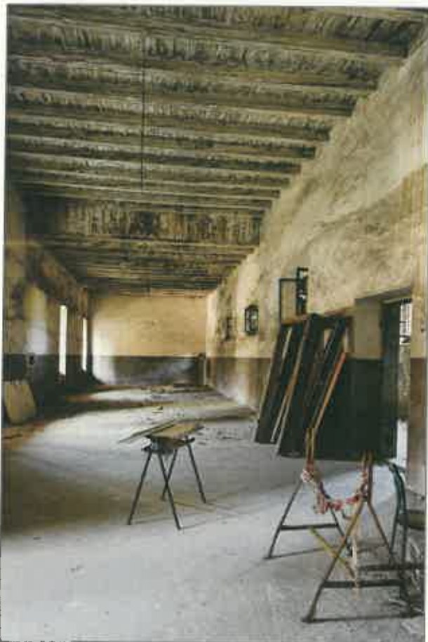
foto 20 – solaio copertura 1°p zona nord, lato portico. Presenza di salto di quota
