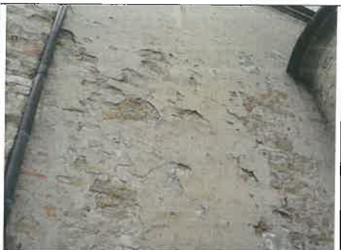
Altra vista della ex chiesa anche qui con prevalenza di intonaco, con ampi fenomeni di mancanza e distacco delle porzioni presenti
