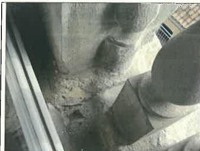
Fenomeni di polverizzazione nella parte passa, dovuta al ristagno delle acque meteoriche
