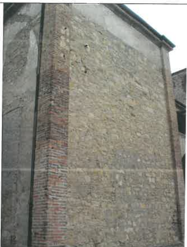
Porzione laterale con spigoli in mattoni a vista, muratura raso-sasso e fascia alta con intonaco cementizio
