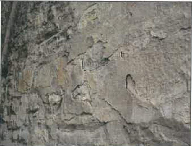
Particolare dei fenomeni di distacco dell'intonaco
