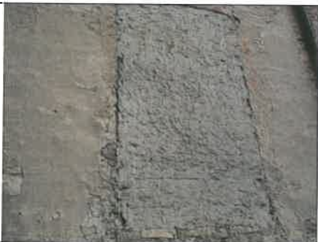
Particolare dell'apertura intonacata con "cemento" in questo caso si provvederà alla rimozione dell'intonaco ed alla reintegrazione con intonaco neutro, solo se facilmente rimovibile, in caso contrario si accompagnerà con una velatura di "riduzione"
