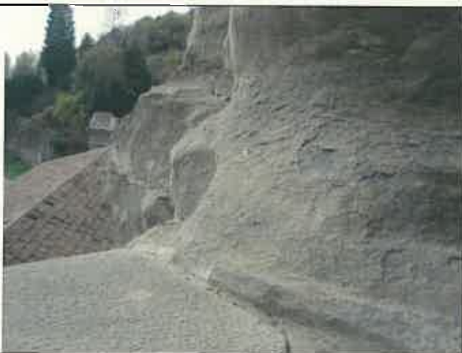
Particolare di una semicolonna laterale, con fenomeni di esfoliazione superficiale
