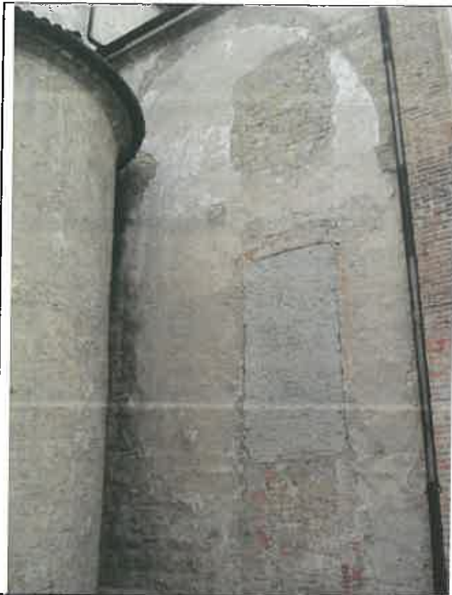
Spicchio trasversale con una finestra tamponata con intonaco cementizio, nella parte alta sono presenti porzioni di intonaco antico
