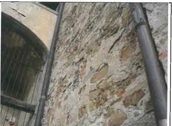
Particolare di una facciata laterale, in questo caso quasi totalmente priva di intonaco, con lacerti in fase di distacco
