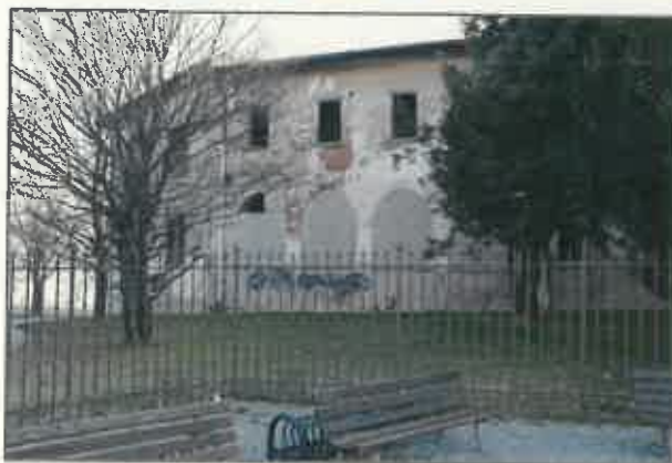
foto 6 – prospetto con tamponature non coeve
