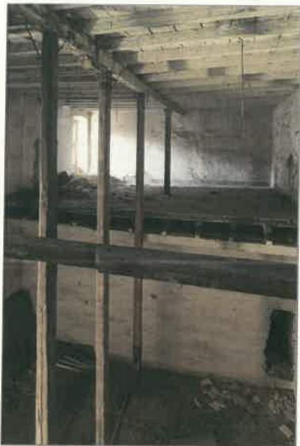
foto 4 – solaio crollato
