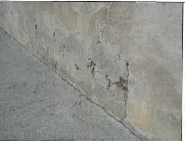
Particolare della parte bassa con intonaco disgregato, per l'azione meccanica dell'acqua e per problemi di umidità di risalita
