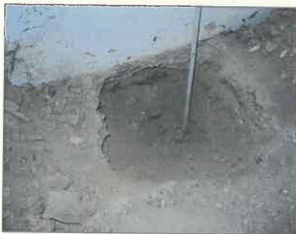
foto 34 – scavo per ispezione fondazioni muro zona scala. Assenza di incremento della sezione.
