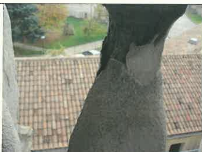
Particolare di una colonnina, con evidenti fenomeni di disgregazione
