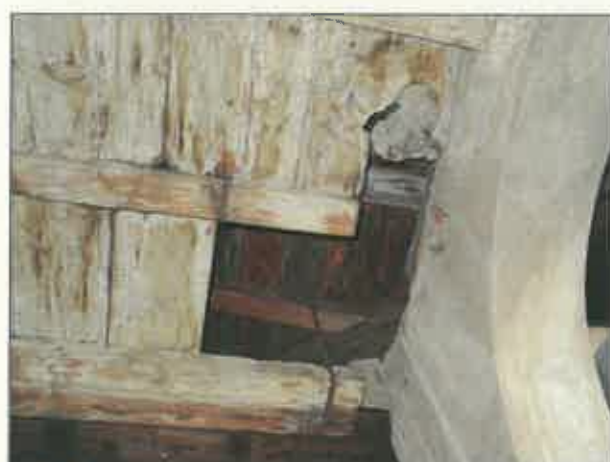
foto 27 – appoggio travetto sottotetto a travetto tetto, tramite staffa
