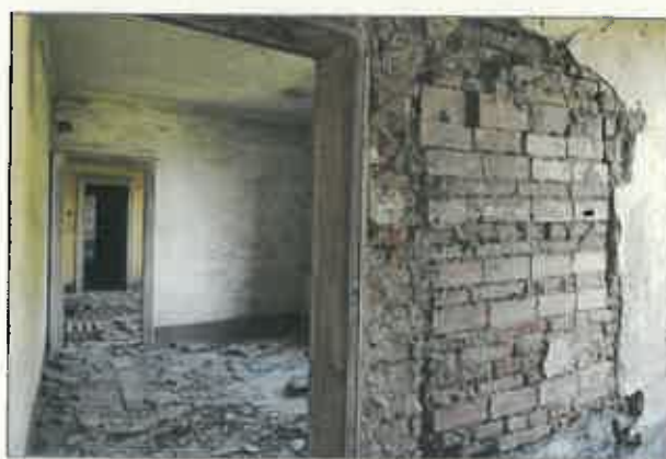
foto 15 – laterizi con giunti allineati – 1°p, nord
