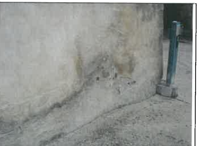
Altro particolare della parte bassa con i medesimi fenomeni di degrado, accelerati dalla presenza delle automobili posteggiate in adiacenza
