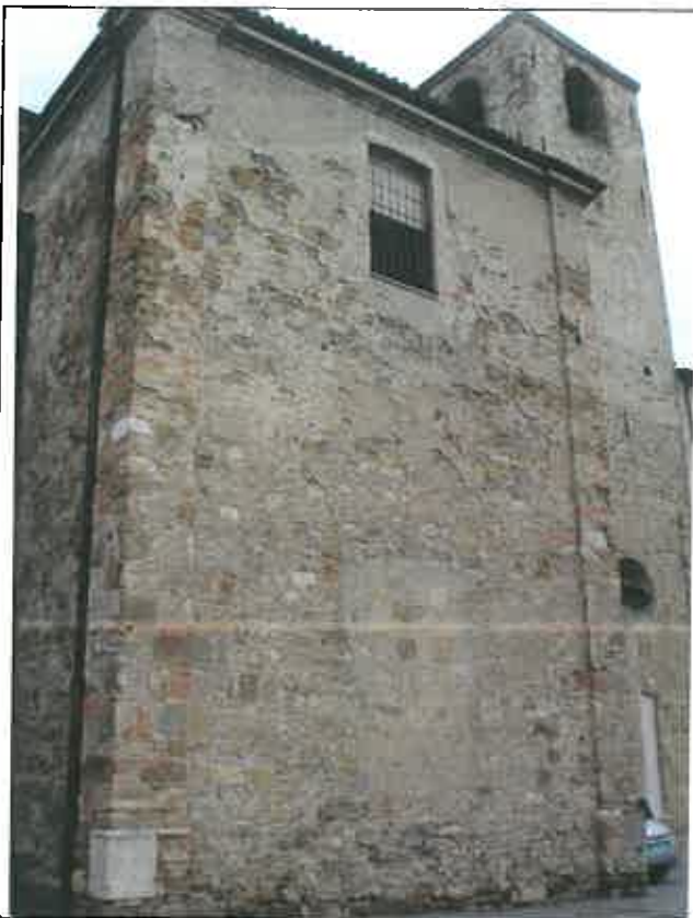
Altra cappella con lacerti di intonaco con evidenti fenomeni di distacco, nella parte bassa è più evidente il fenomeno di disgregazione dovuta all'azione diretta dell'acqua
