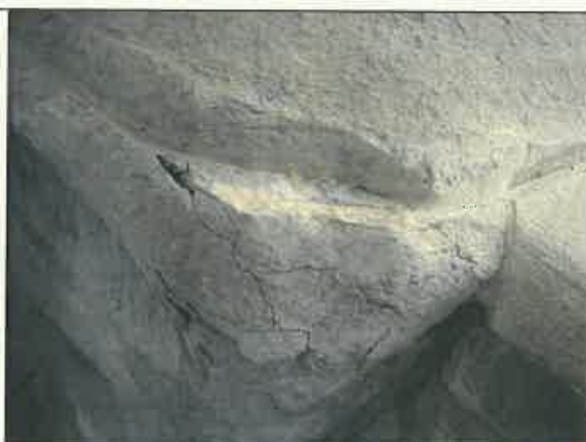
Particolare di uno spigolo, del basamento di una colonna, profondamente fessurato
