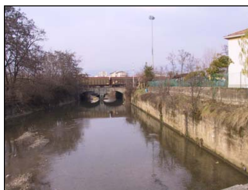
Foto 11: tratto del torrente Morla in corrispondenza dell'attraversamento della stazione ferroviaria.
