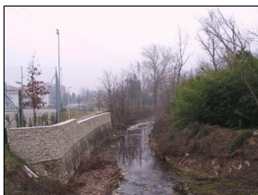
Foto 10: tratto del torrente Morla poco a valle dell'ingresso nell'area urbanizzata.
