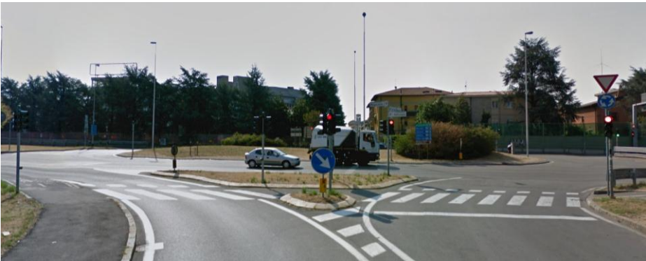
Foto 11 – Intersezione 1 Ramo C – direzione sud
