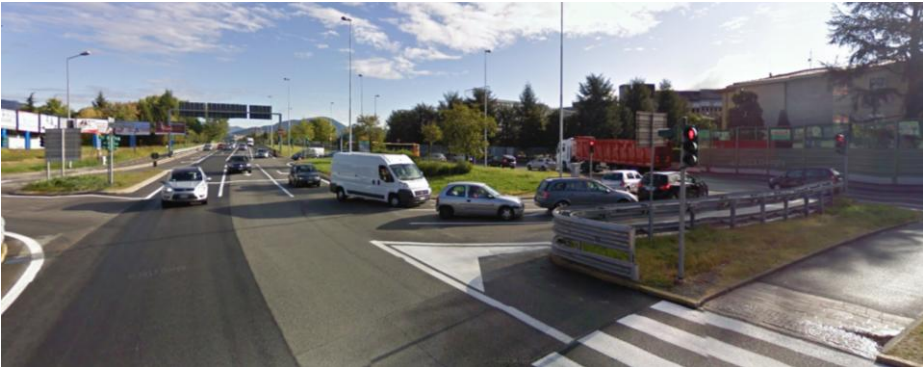
Foto 10 – Intersezione 1 Ramo D – direzione est
