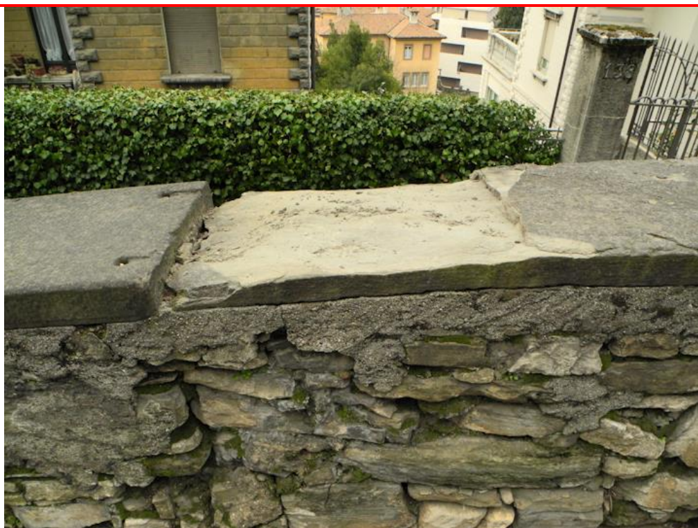
Fratturazione, esfoliazione della copertina in pietra, e parziale mancanza
