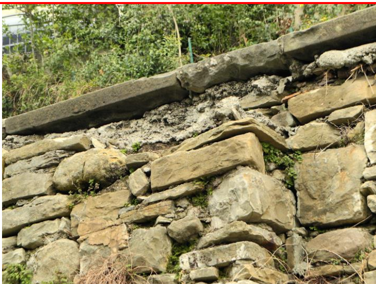
Particolare della copertina del parapetto con distacchi e disgregazioni
