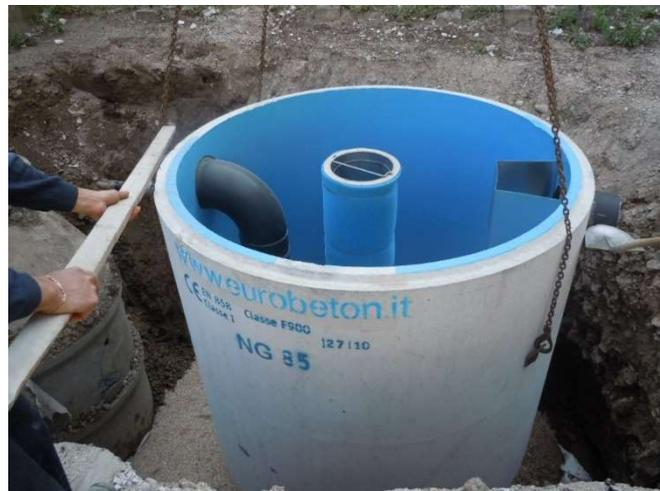
Per la scelta e il dimensionamento del dispositivo di separazione degli oli si è fatto riferimento alla norma UNI EN 858-1 "Impianti di separazione per liquidi leggeri (ad esempio benzina e petrolio) – scelta delle dimensioni nominali, installazione esercizio e manutenzione" – giugno 2004.
