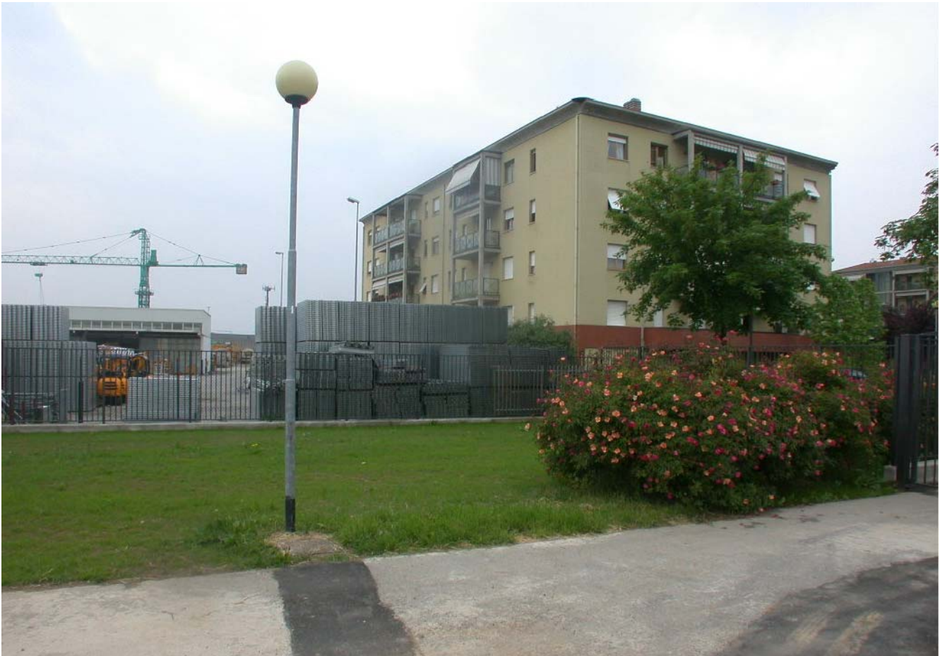
Fig. 6: vista dell'area dal parco pubblico esistente
