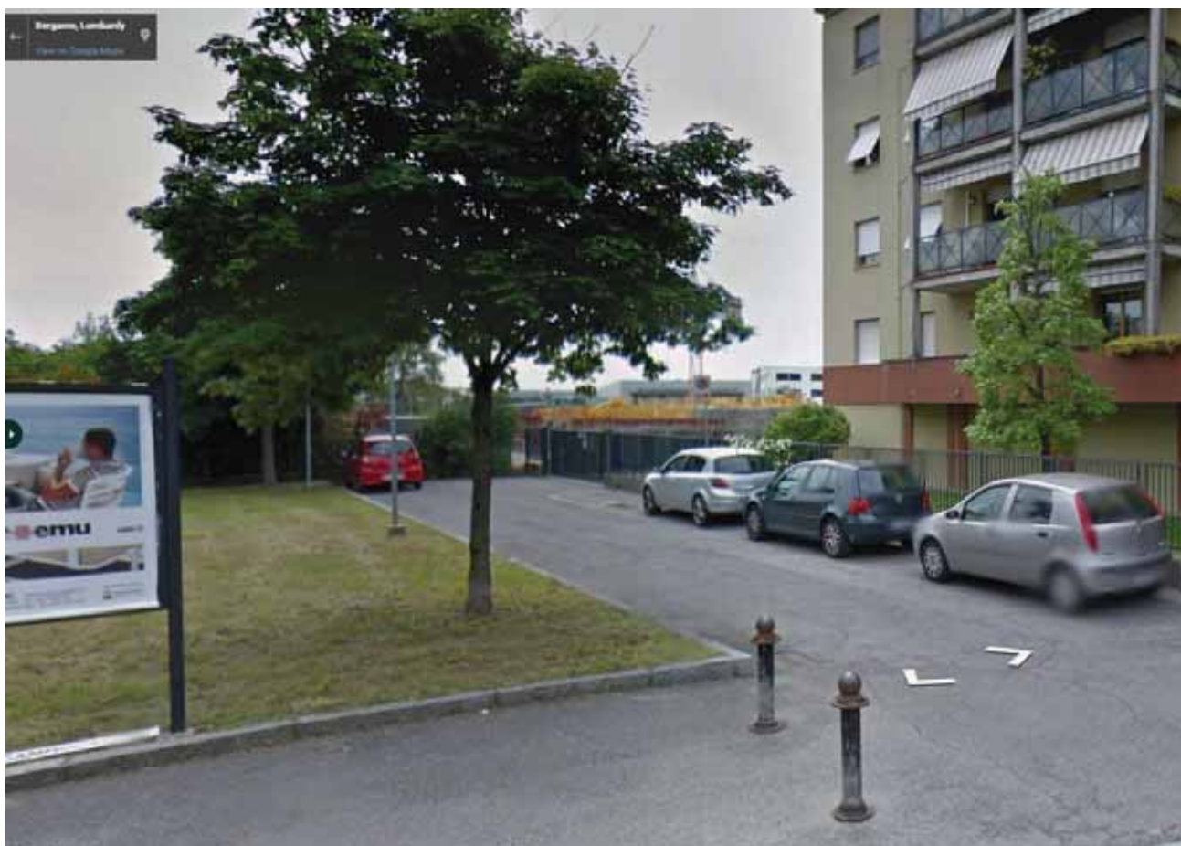
Figura 27: Stato di fatto da via Lorenzo Perosi (vista ingresso). Fonte: Google Street View, 2021.
