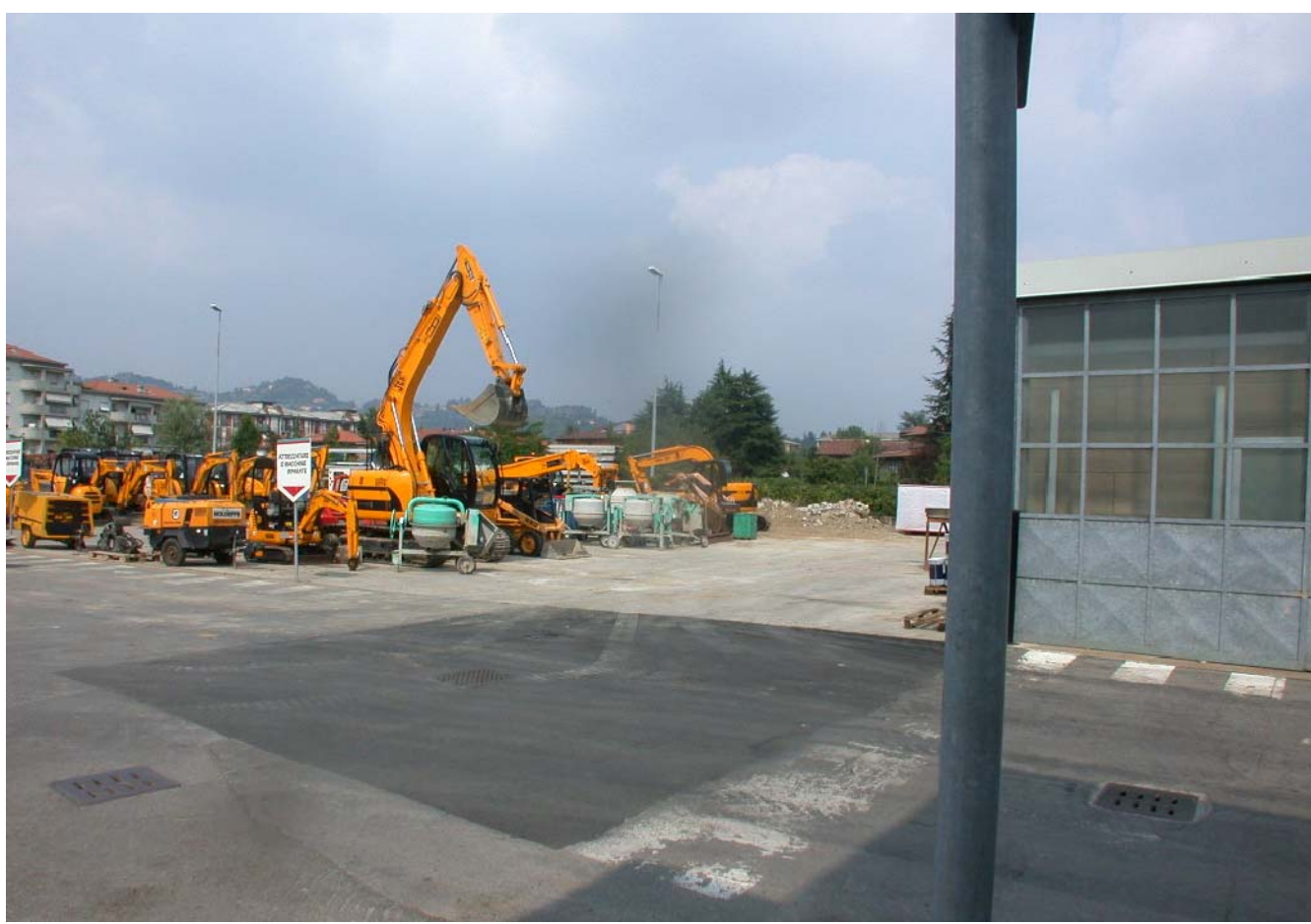
Fig. 2: vista dell'area da ovest
