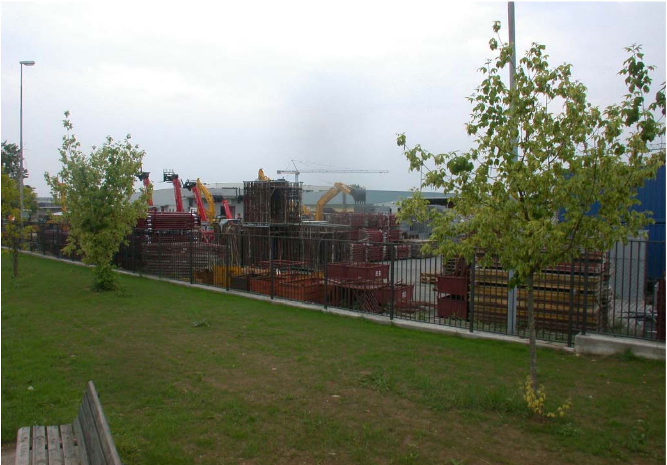
Fig. 4: vista verso sud dell'area
