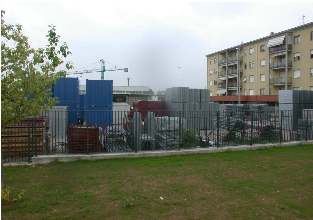
Fig. 5: Vista dell'area da Est verso Ovest
