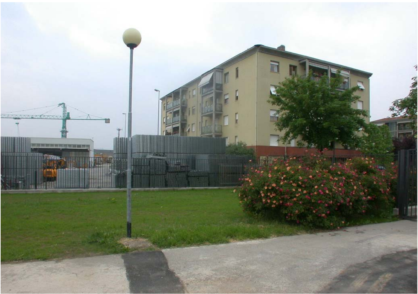
Fig. 6: vista dell'area dal parco pubblico esistente
