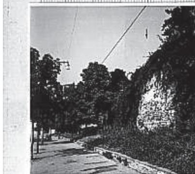
Nella porzione orientale del muro le pietre sono legate con una caratteristica malta rosata (calce e coccopesto), ciò dà al muro al secolo XVII.
