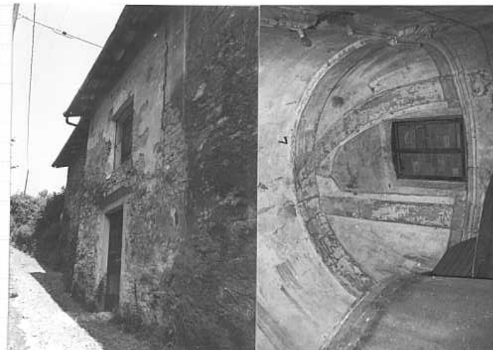
Elementi in pietra e mattoni con decorazioni in stucco
