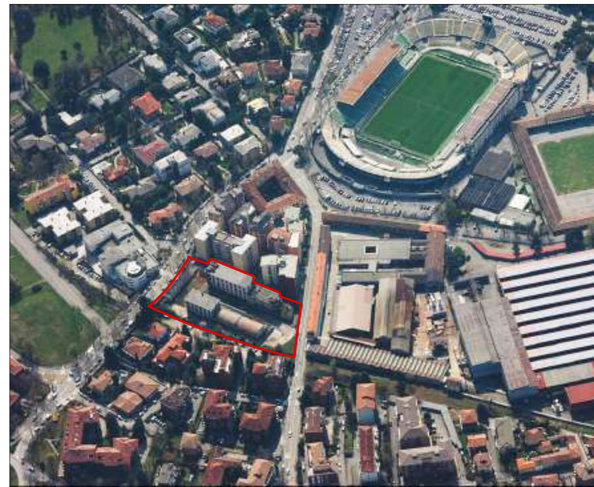
STATO DI FATTO: VISTA AEREA 04
