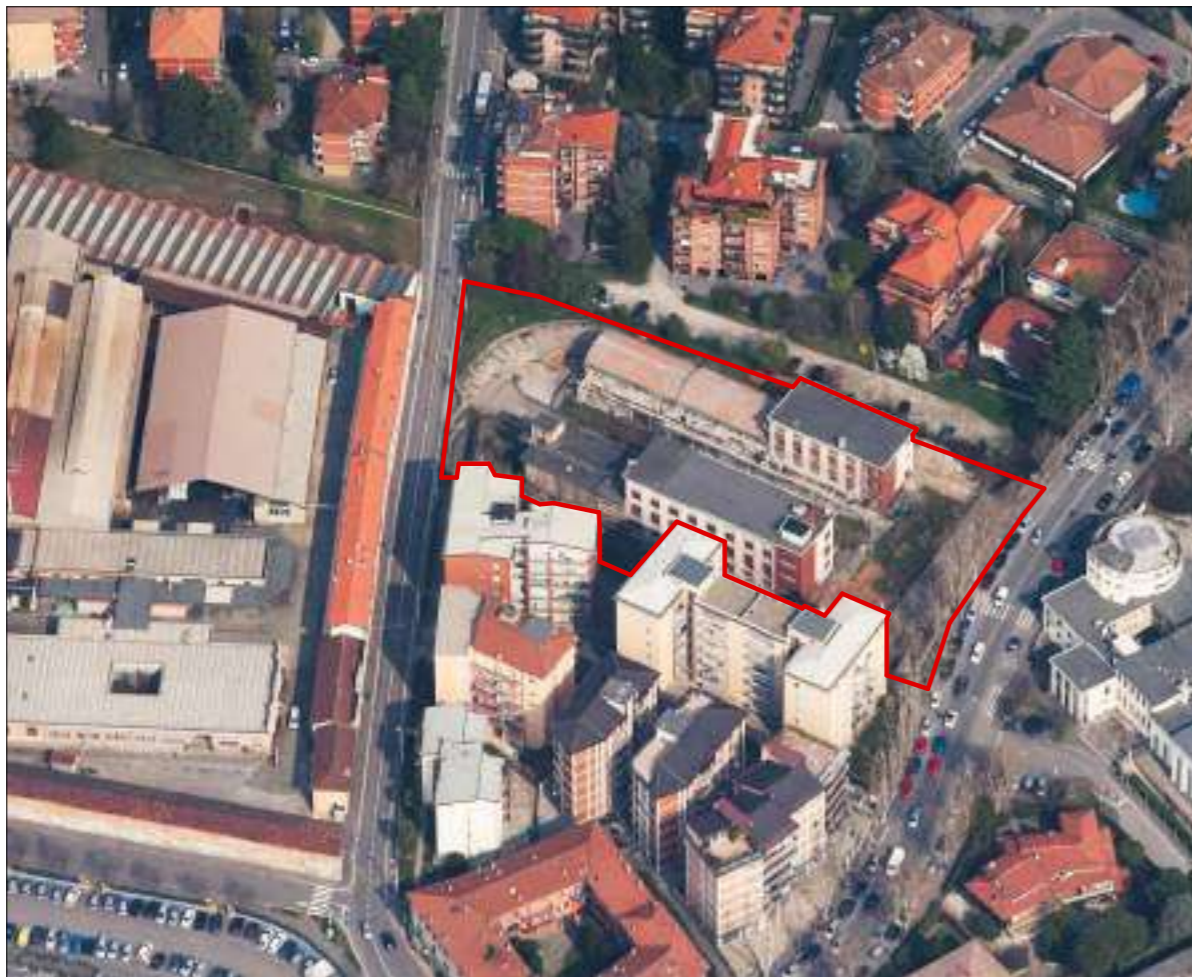
STATO DI FATTO: VISTA AEREA 01
