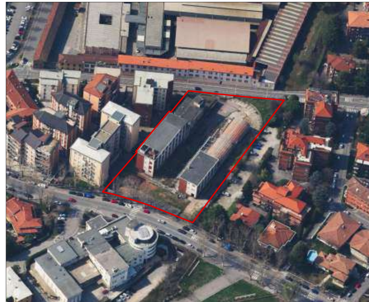
STATO DI FATTO: VISTA AEREA 02
