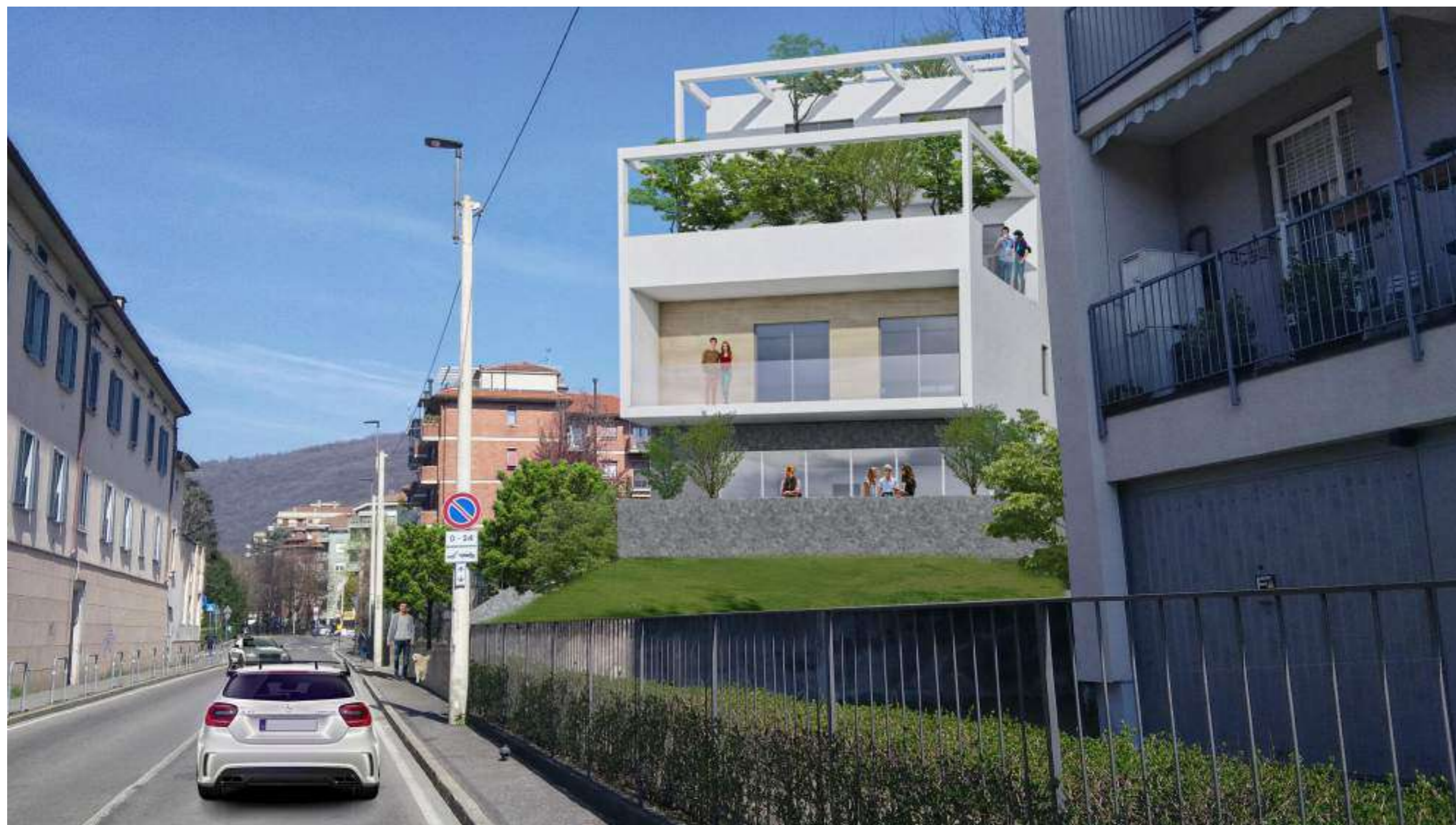
VISTA DI DETTAGLIO DA VIA P. PIETRA 02
