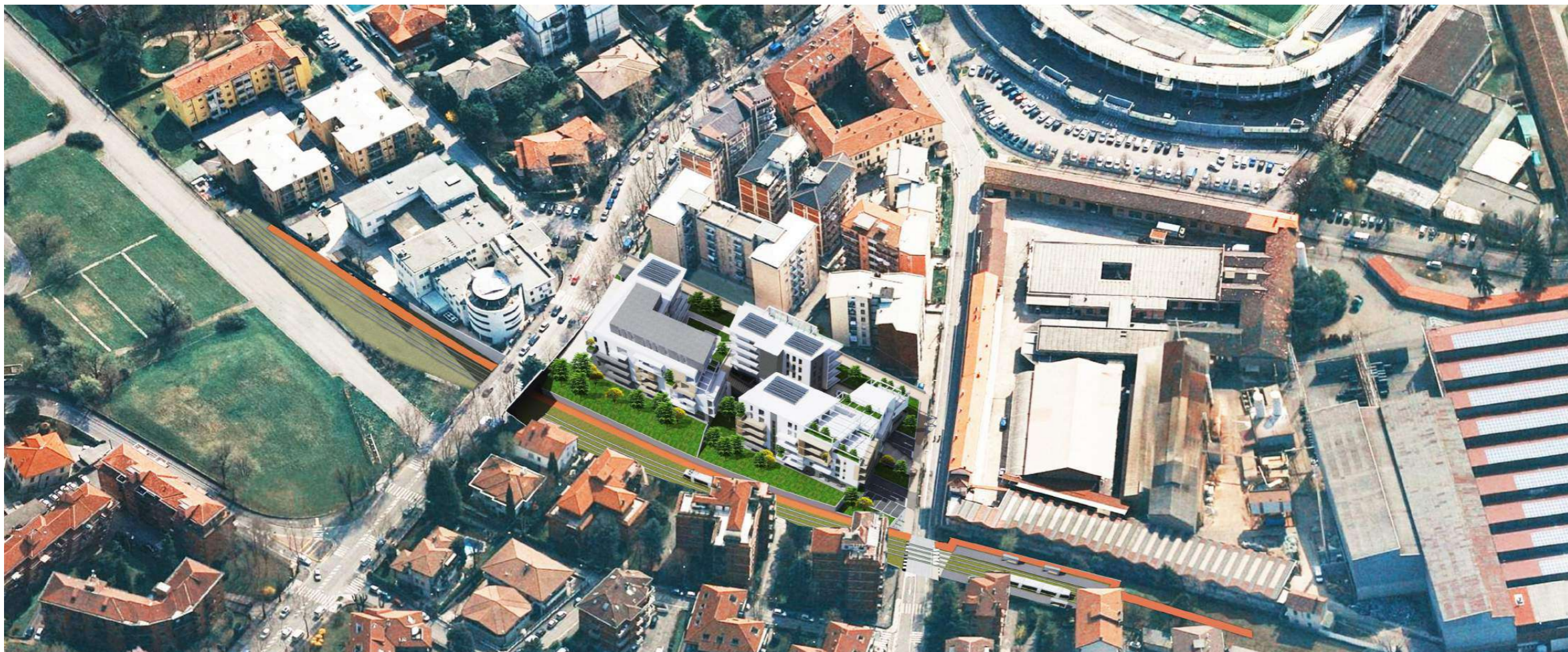
VISTA AEREA DA NORD
