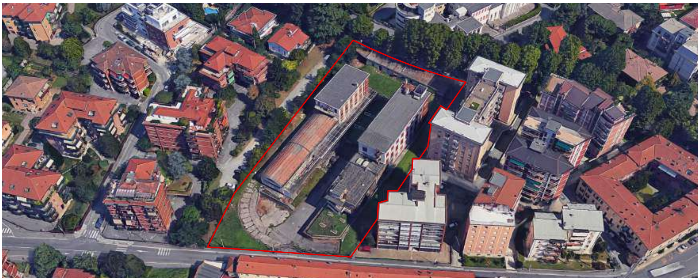
STATO DI FATTO: VISTA AEREA DA OVEST
