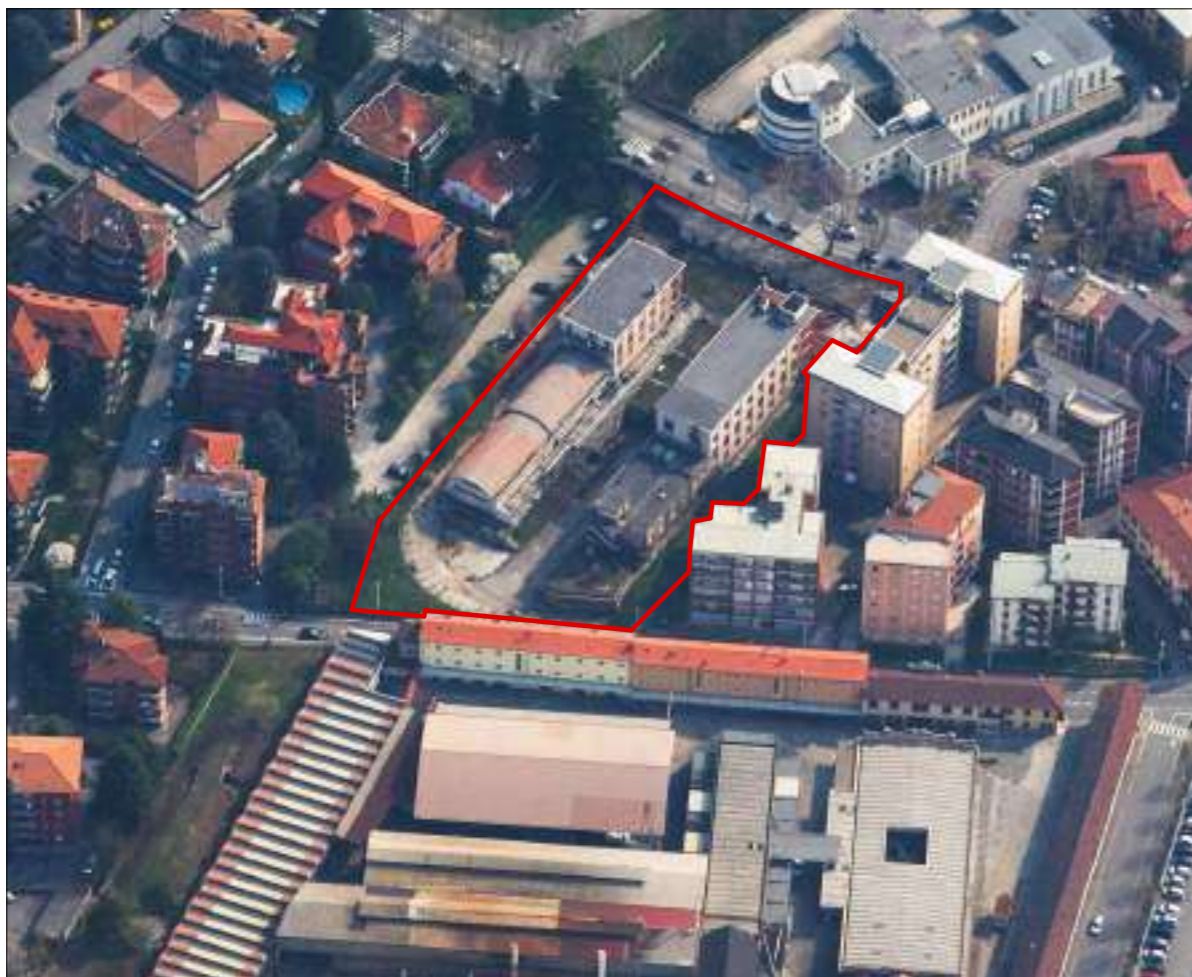
STATO DI FATTO: VISTA AEREA 03
